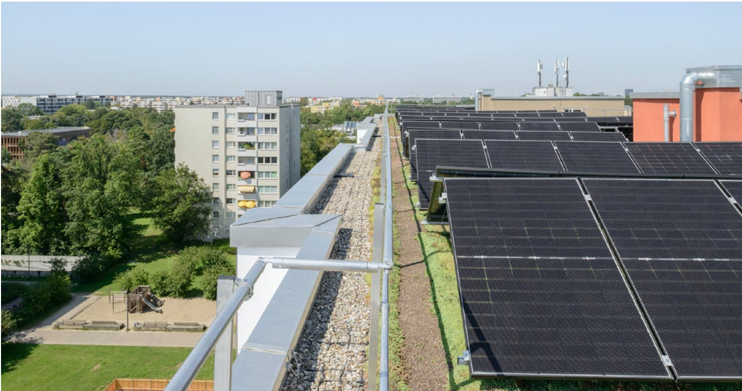
Die Solaranlage auf dem erneuerten und nun wärmedämmten Gründach der energetischen Sanierung der Münchner Wohnen am Karl-Marx-Ring 11 – 21. Fotos: Münchner Wohnen/PK Odessa, Lanz
